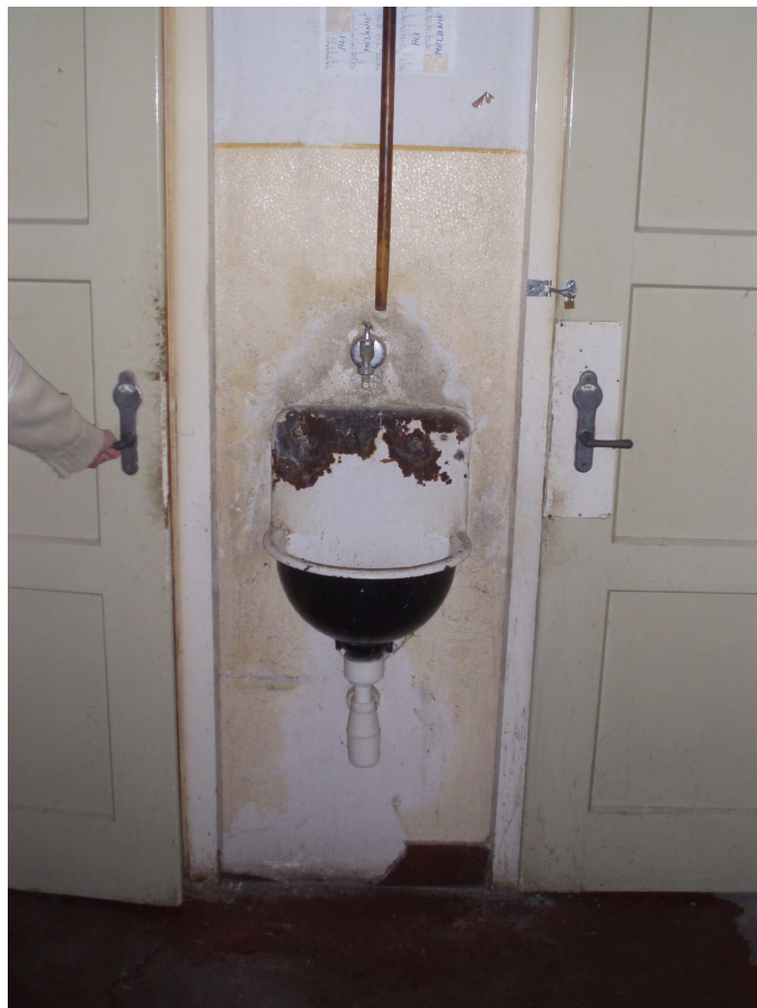
Abbildung 3: Toiletten am Gang
